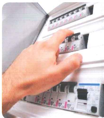
Een zekering onderbreekt de stroomkring bij kortsluiting.
